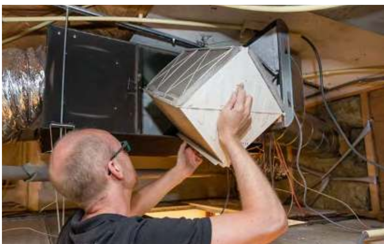
Filters van het ventilatiesysteem moeten regelmatig worden vervangen.
