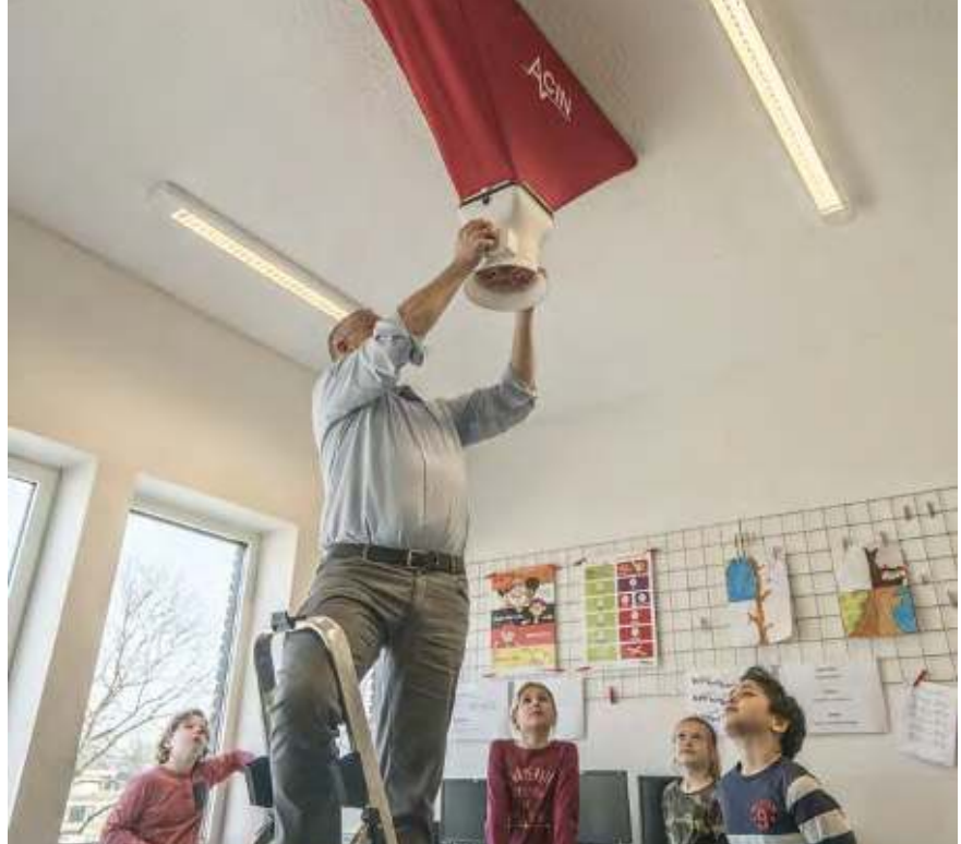
Uitvoeren van debietmetingen in een klaslokaal.
