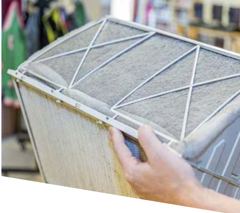
Filters van het ventilatiesysteem moeten regelmatig worden vervangen.
